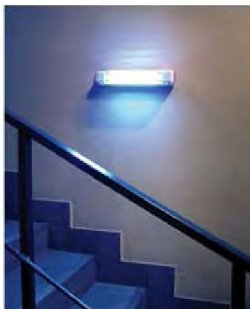
аварийное освещение путей эвакуации
